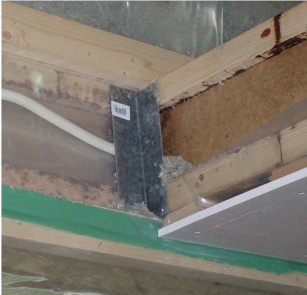
Figur 8. Lätt mellanbjälklag ansluter mot yttervägg med obrutet tätskikt.
