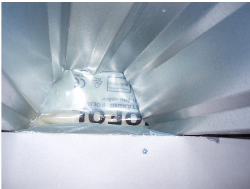
Figur 6. Plastfolie i kontakt med vassa plåtkanter.
