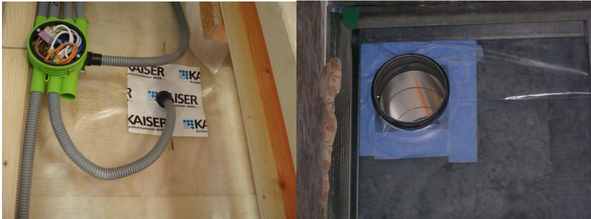
Figur 9. Elgenomföring med stos samt ventilationskanal med extra plastfolie och tejsning mot tätskikt och mot rör.
