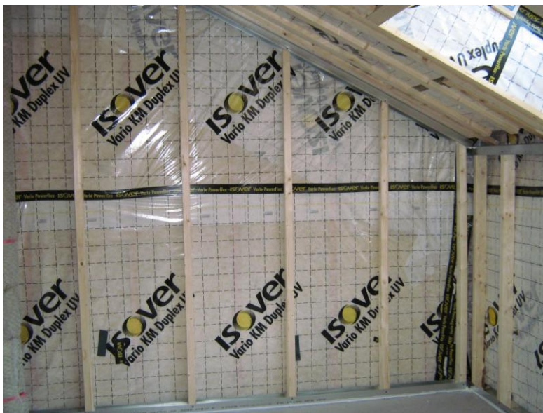
Figur 4. Exempel på indraget tätskikt (innan inre isolering är på plats).
